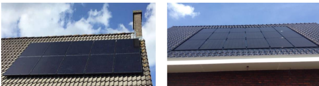
1 Op-dak (links) en in-dak (rechts) zonnepaneelsystemen
