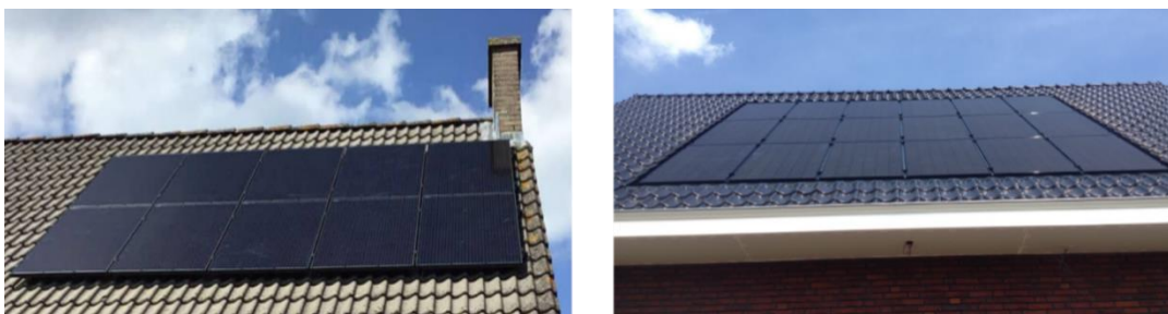
1 Op-dak (links) en in-dak (rechts) zonnepaneelsystemen
