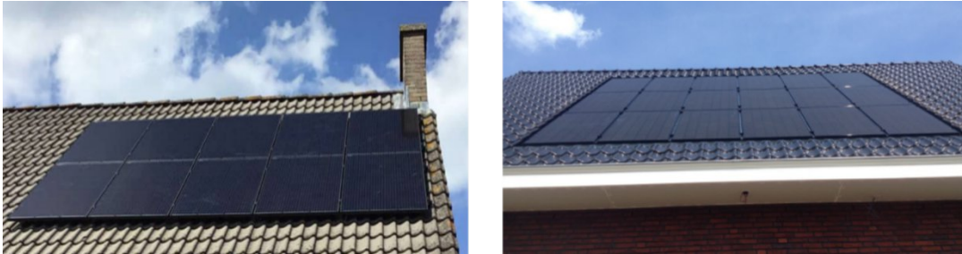
1 Op-dak (links) en in-dak (rechts) zonnepaneelsystemen
