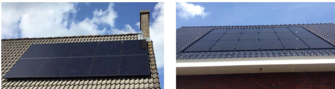
1 Op-dak (links) en in-dak (rechts) zonnepaneelsystemen
