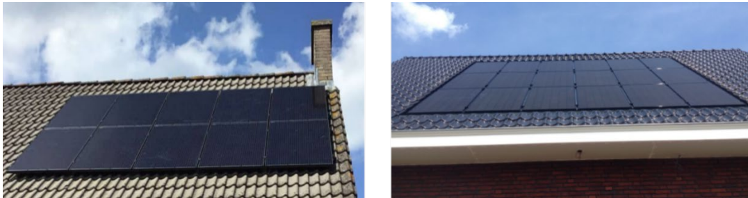
1 Op-dak (links) en in-dak (rechts) zonnepaneelsystemen
